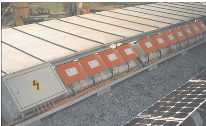
String-Wechselrichter Sunny Boy 700
